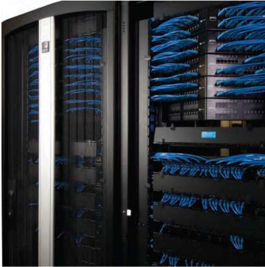
图例（十七）：Teraframe 机柜手指型垂直理线器和角型配线架应用（理线器带面板盖）
